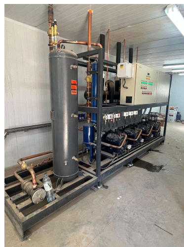
CENTRAL DE FRIO Y CAÑERIAS DE COBRE
