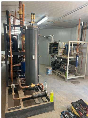
CENTRAL DE FRIO Y CAÑERIAS DE COBRE
