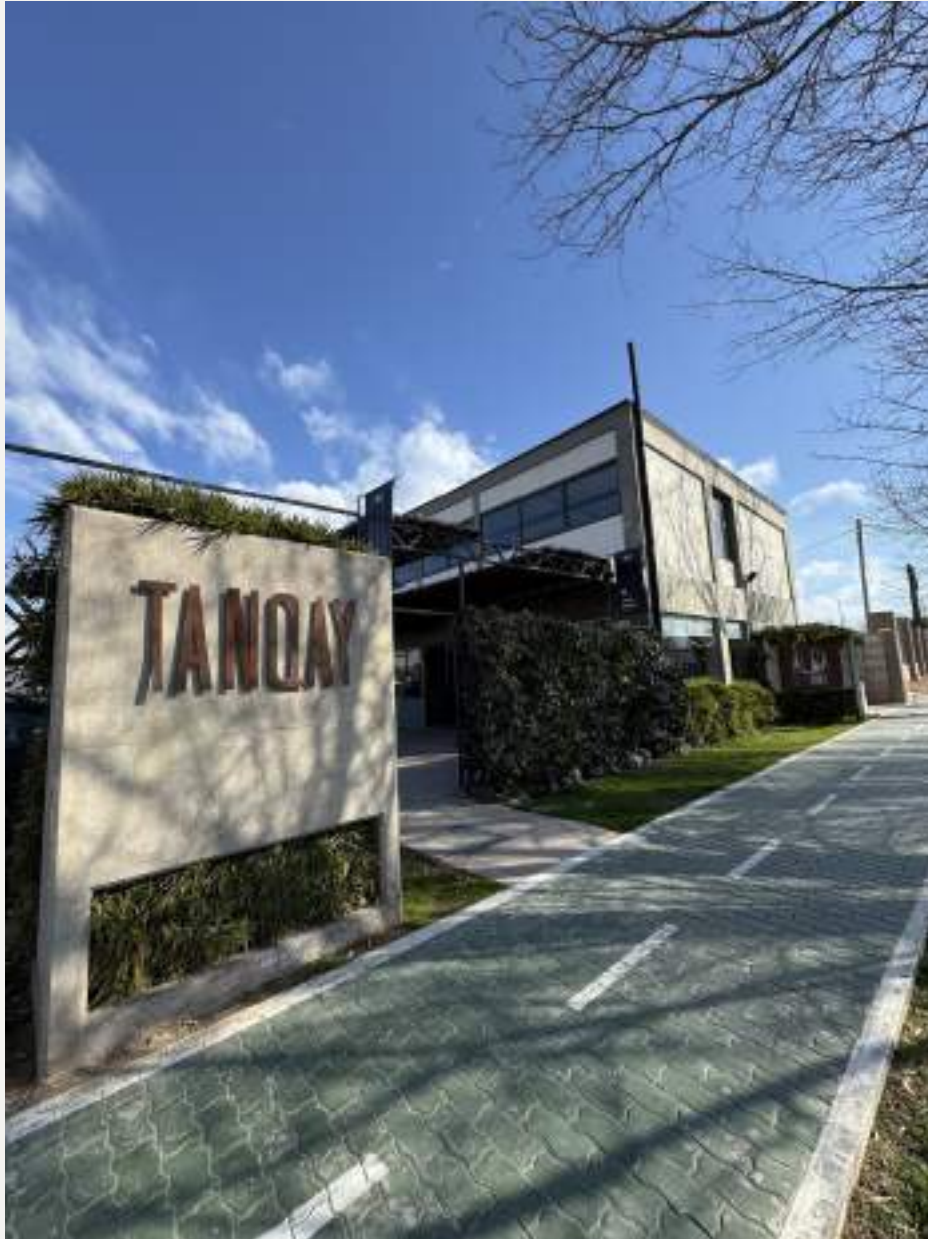
Acceso: monolito de hormigón con la marca Tanqay y el volumen comercial detrás.
