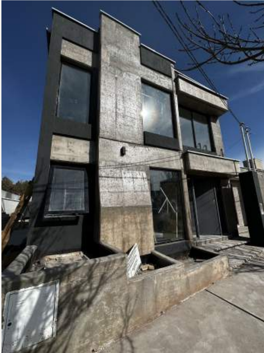
La misma fachada durante la obra. El plano quebrado y los huecos ya están definidos en la estructura.
