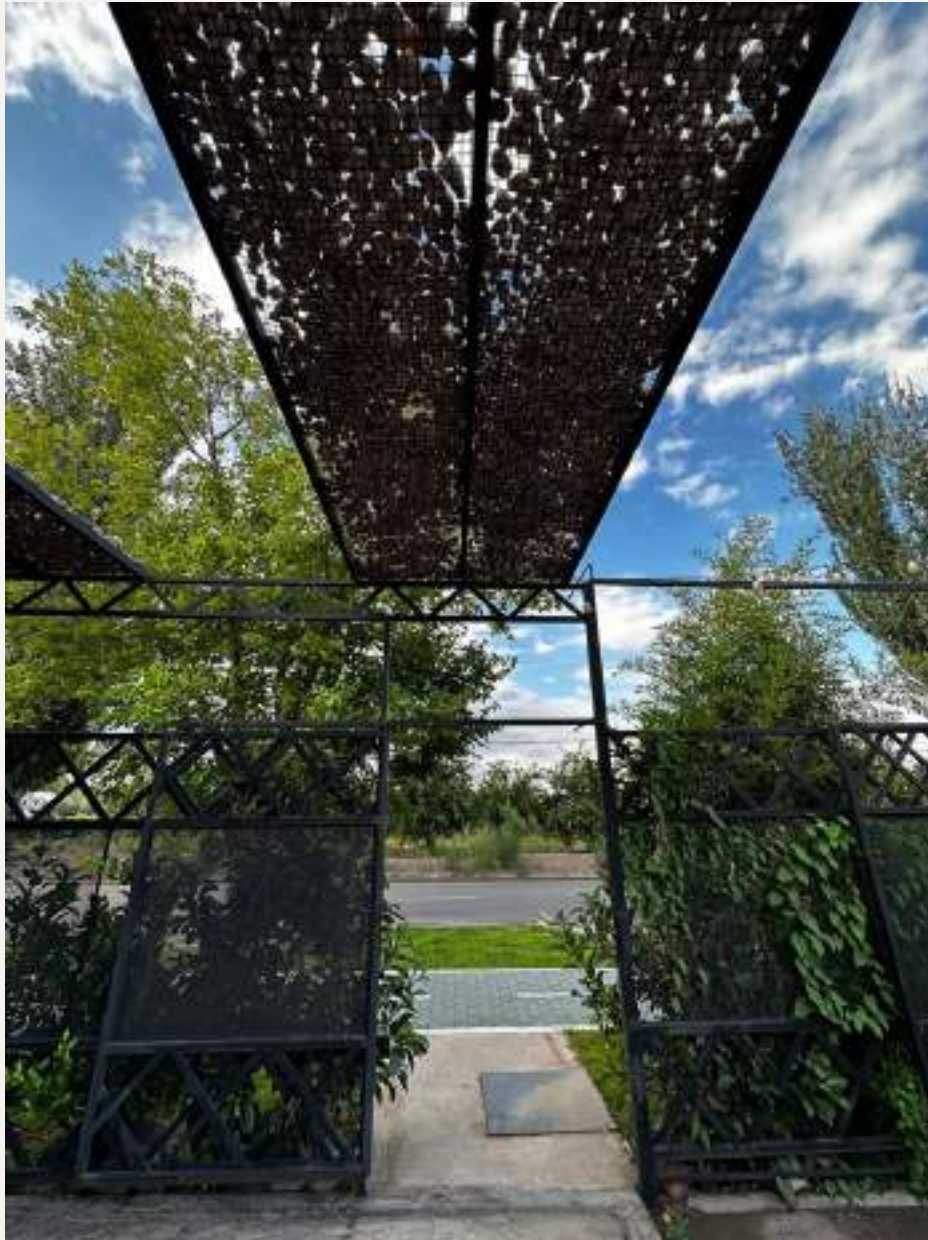
Pérgola de acceso peatonal con vegetación y estructura metálica negra.
