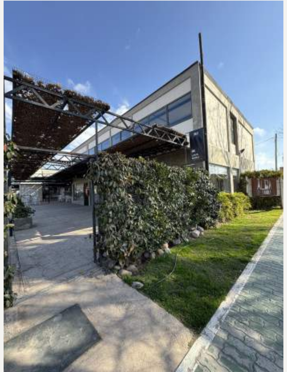
Encuentro entre el volumen de planta alta y la estructura de parasoles.
