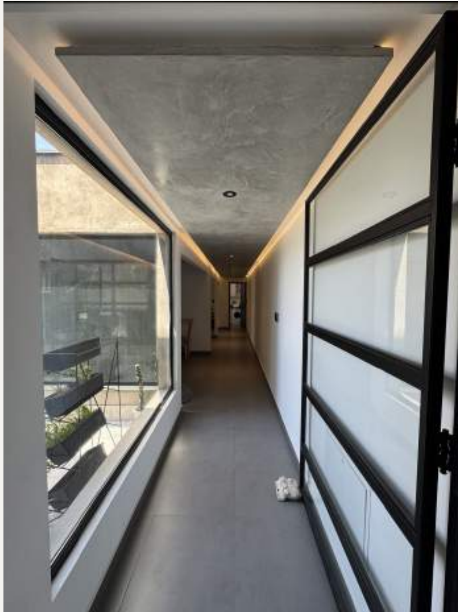
Puerta corrediza de vidrio armado y cielorraso de hormigón con luz de cornisa.
